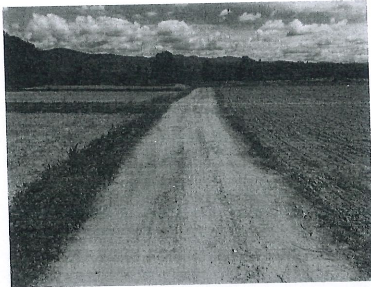
ก่อสร้างถนน คสล.สายทรัพย์ไพวัลย์ หมู่ที่ ๙ บ้านโพนทอง ตำบลบ้านฝาย อำเภอน้ำปาด จังหวัดอุตรดิตถ์
