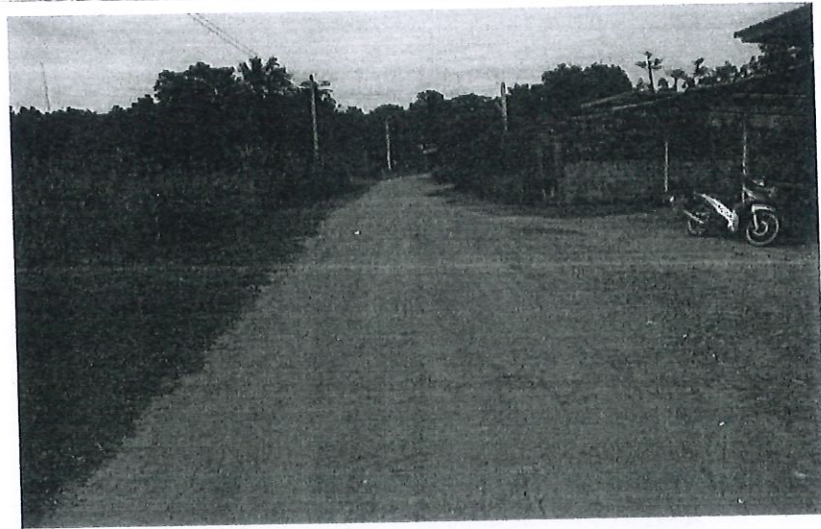
ก่อสร้างถนนคอนกรีตเสริมเหล็ก สายกกแหน หมู่ที่ ๒ บ้านใหม่ ตำบลบ้านฝาย อำเภอน้ำปาด จังหวัดอุตรดิตถ์
