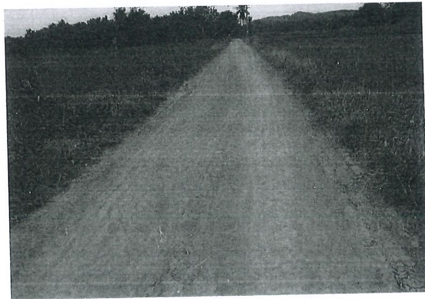
ก่อสร้างถนนคอนกรีตเสริมเหล็ก สายดงแดง - ริมแม่น้ำปาด หมู่ที่ ๑ บ้านฝาย ตำบลบ้านฝาย อำเภอน้ำปาด จังหวัดอุตรดิตถ์
