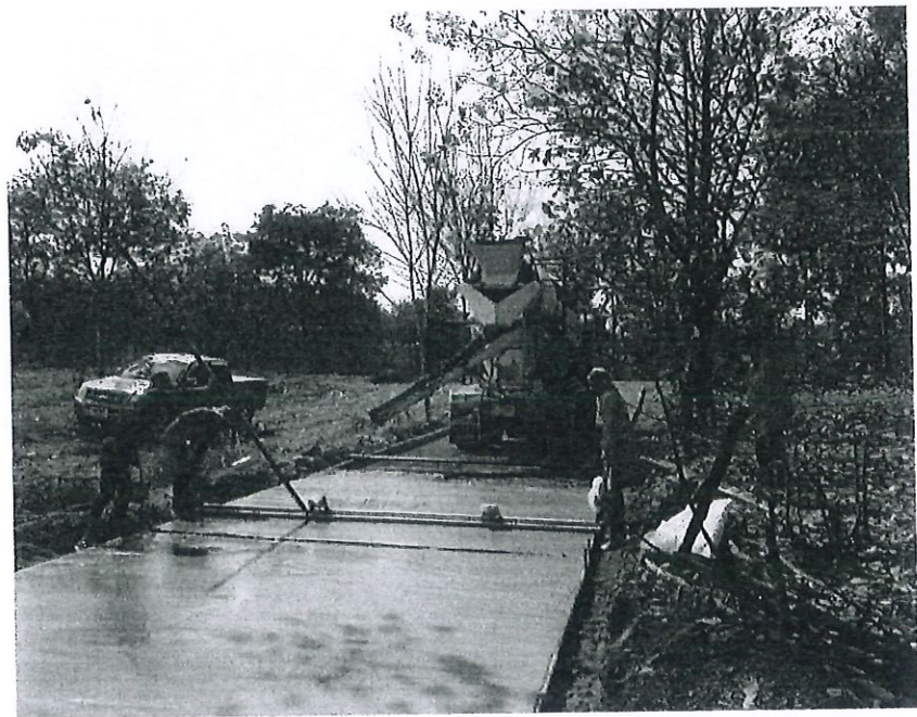
ก่อสร้างถนนคอนกรีตเสริมเหล็ก สายนาห้วยแล้ง หมู่ที่ 4 บ้านม่วง ตำบลบ้านฝาย อำเภอน้ำปาด จังหวัดอุตรดิตถ์
