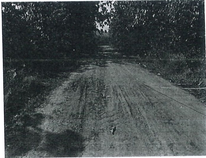
ก่อสร้างถนน คสล.สายหนองกองแก้ว หมู่ที่ ๕ บ้านทรายขาว ตำบลบ้านฝาย อำเภอน้ำปาด จังหวัดอุตรดิตถ์
